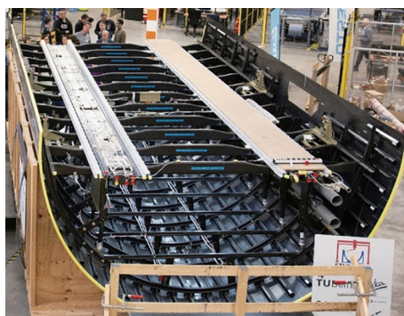
图 14 组装完成后的机身下部 [26]
