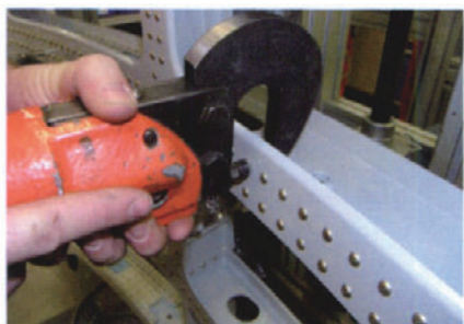
图2 铆钉的手工安装
