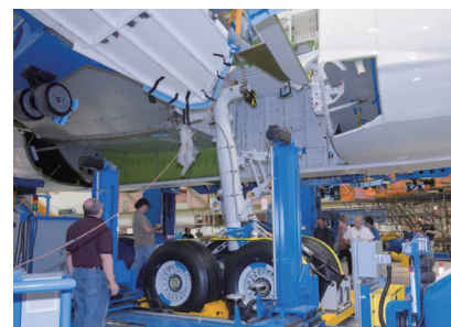
图4 主起落架安装
