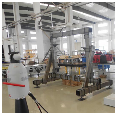
图10 工装安装现场
