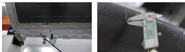
(a) 左侧段铺放 (b) 机翼前缘(局部)铺放
