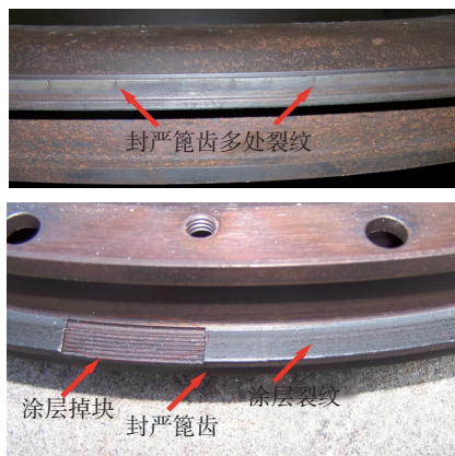
图1 涂层裂纹及掉块的宏观形貌
