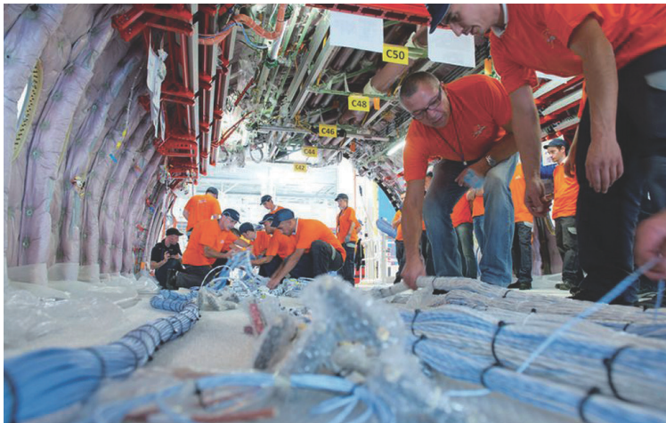
图4 一体化数字解决方案确保A350XWB电气线束物理安装高效开展
